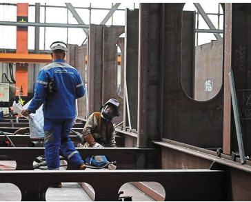
Le port de Saint-Nazaire avec les chantiers de l'Atlantique, construction de paquebots. (Photo Franck Dubray)
