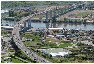
Le pont de Cheviré va vivre une semaine sans voiture pour de nécessaires travaux d'entretien. Le début du casse-tête pour les automobilistes. (Photo : Archives France Presse)
