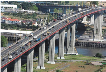
Le pont de Cheviré, ouvrage d'1,5 kilomètre de long à l'ouest du périphérique nantais, va faire l'objet d'un gros chantier à partir de lundi à vendredi.
